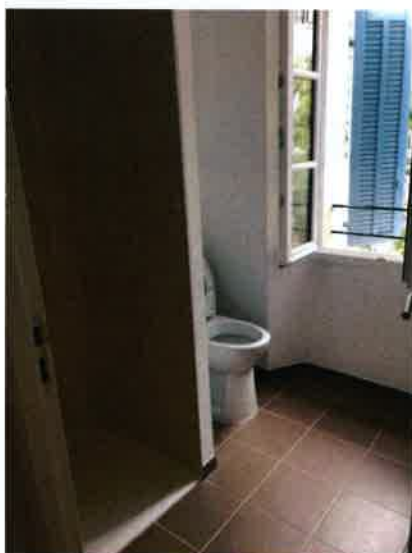
Salle de douche :
