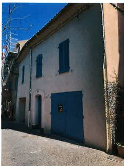
Façade côté rue :
